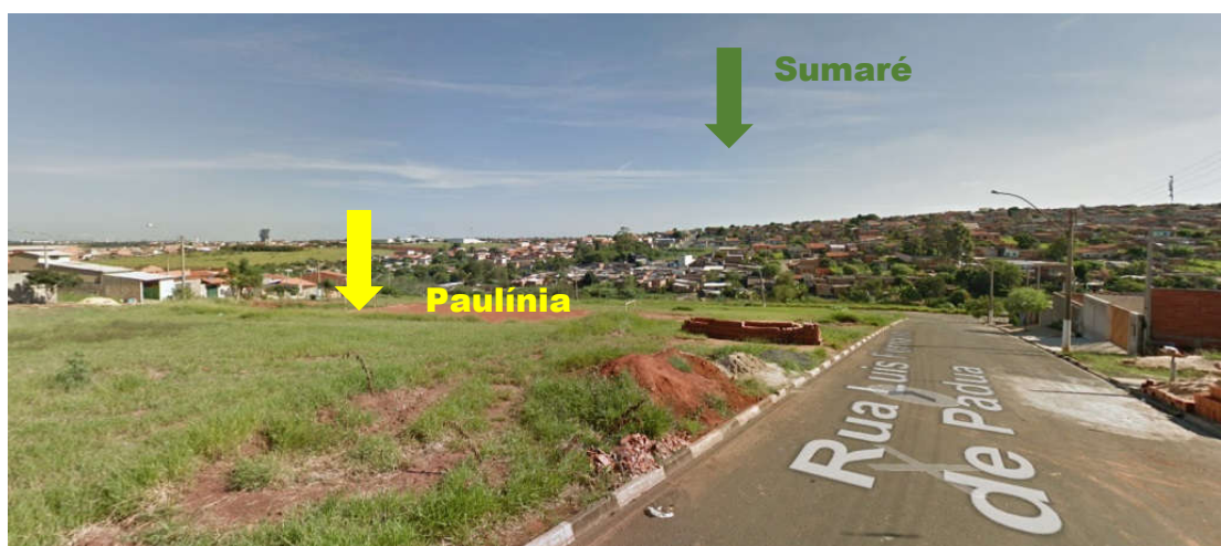
Figura 87 – Conurbação entre Sumaré e Paulínia – Vista de Paulínia
