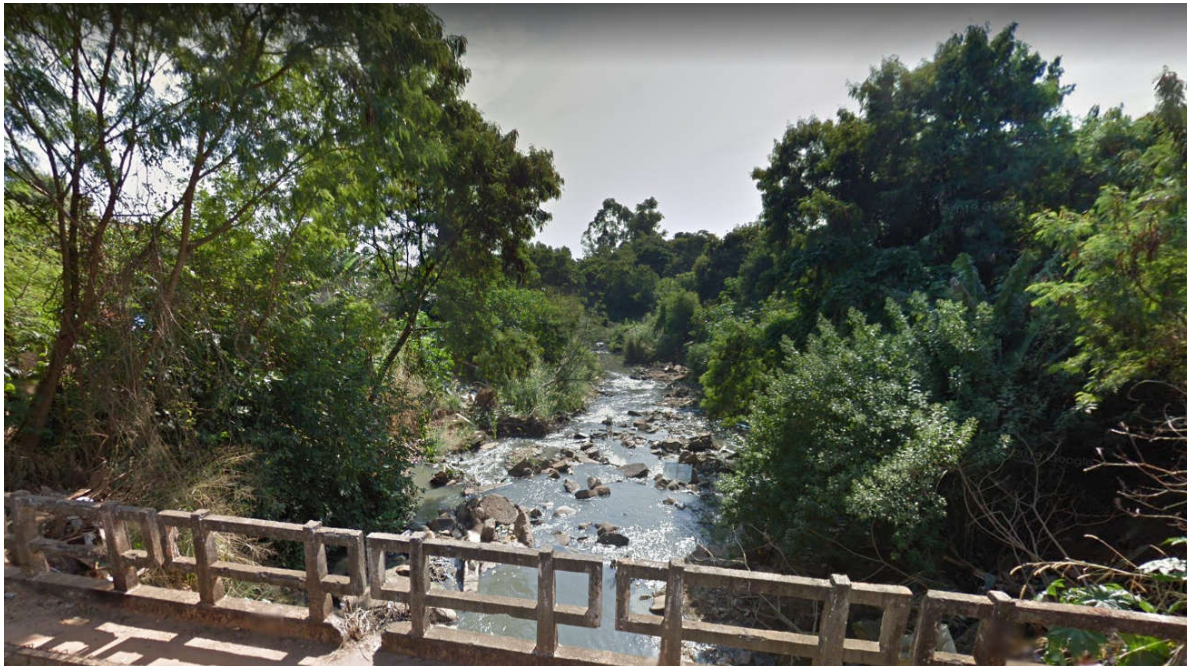
Figura 133 – Córrego Tijuco Preto visto pela Ponte do Jd Nova Terra
