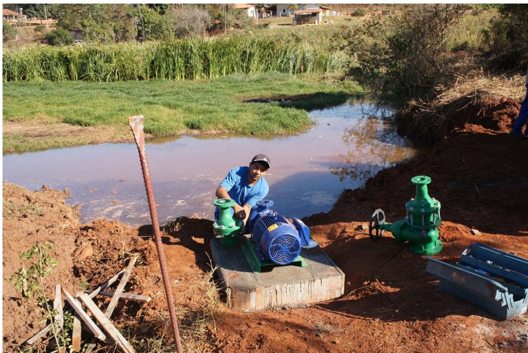
Figura 114 – Parque Linear do Córrego Palmital - Manutenção CODEN
